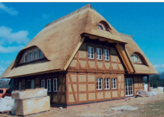
Haus Grüssow ausgefacht mit Lehmsteinen
